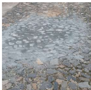
Pequenas reparações nas vias alcatroadas e calçadas
