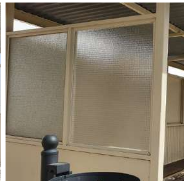
Substituição de vidros partidos
