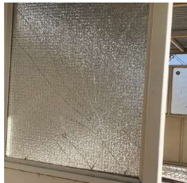
Substituição de vidros partidos
