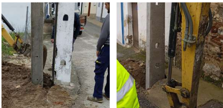
Substituição de postes de iluminação e acerto dos relógios
